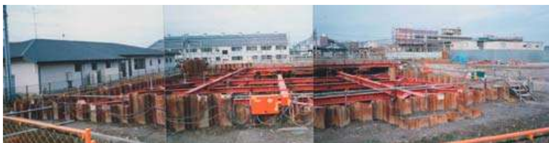
【工事中の様子】
