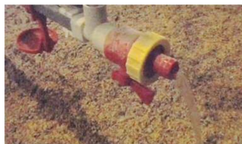
写真 1：給水ラインの水抜き
