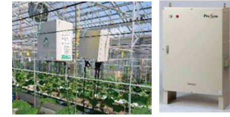
【施設栽培における環境モニタリング装置（左）と統合環境制御装置（右）】
