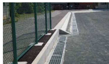
周囲小堤と集水側溝
