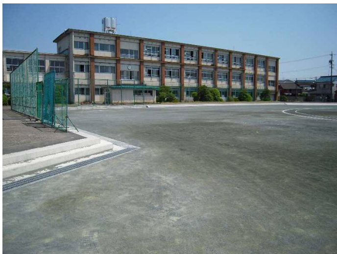
グラウンド貯留部
