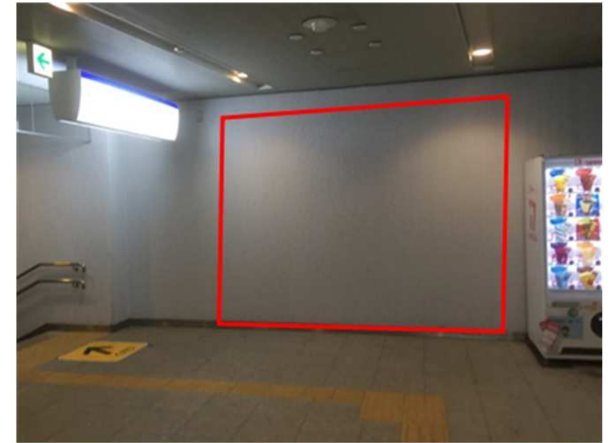
ホームとの昇降口手前の壁
