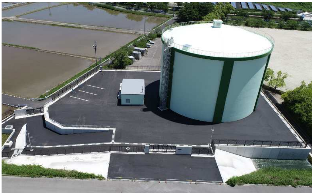
海部広域調整池
