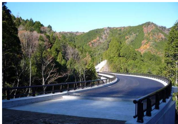
広域農道奥三河地区（橋梁工事の実施状況）
