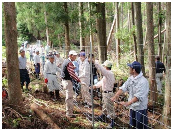
侵入防止柵設置状況
