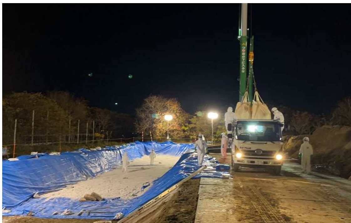
愛知県農業土木研究会東三支部による埋却作業の様子
