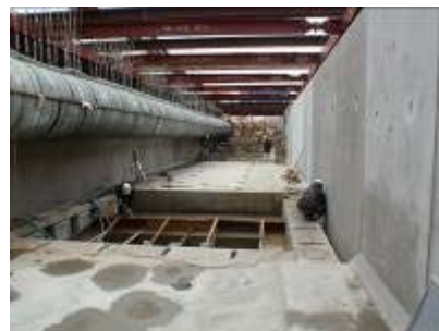
かんがい排水事業中井筋地区(工事中 排水路)
