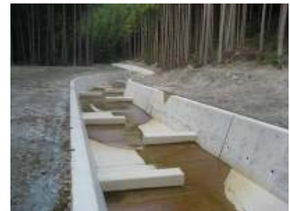
治山施設(流路工)
