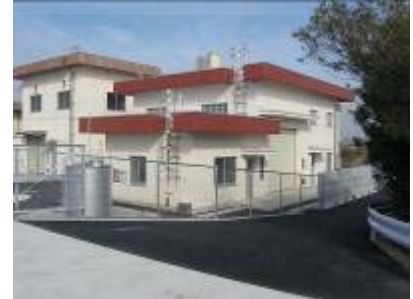
たん水防除事業一色西部地区 (一色西部排水機場)
