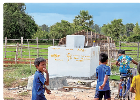
小学校に寄贈した手洗い場（建設中）
