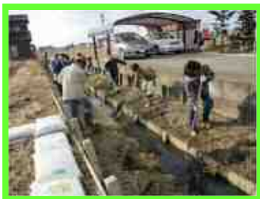
水路の泥上げ
