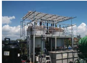
水熱処理を施した下水汚泥と生ごみの混合消化試験
