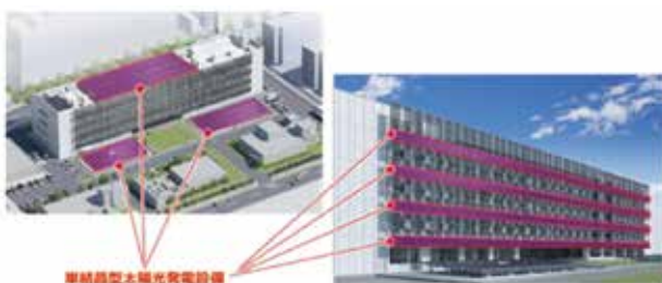
図11 単結晶型太陽光発電設備
