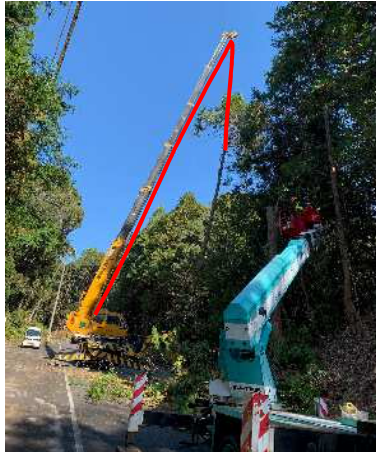
クレーンによる集材（新城市） ※木を吊り上げて固定して伐採し、玉切り後、トラックに積み込んで移動
