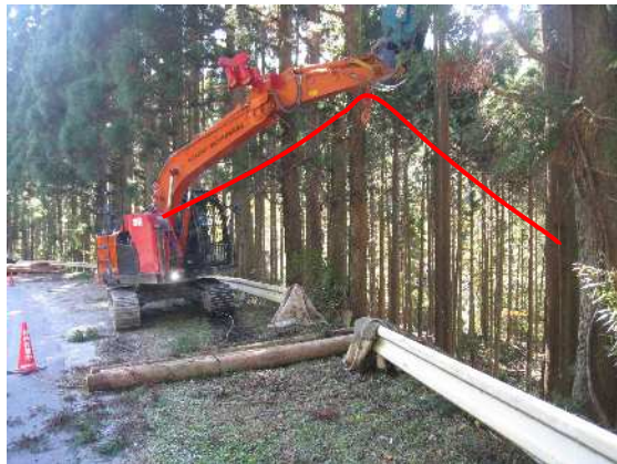
木寄せウインチによる集材（豊田市） ※ワイヤーで丸太を引き寄せる荷役機械
