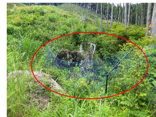
倒木により折れ曲がった獣害防止柵
