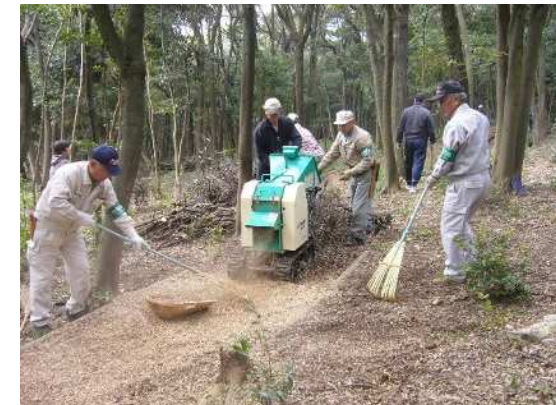
樹木粉碎機でチップ化し散策道に敷設
