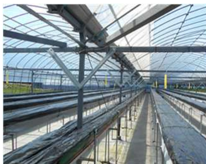
【補強例：アングル固定】
