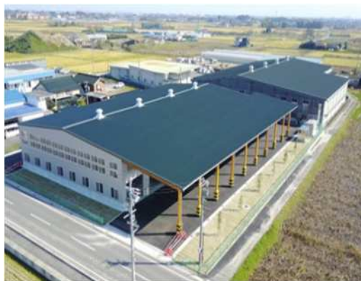
JAあいち海部 いちご集出荷施設
