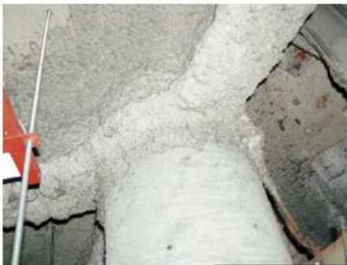
鉄骨耐火被覆
