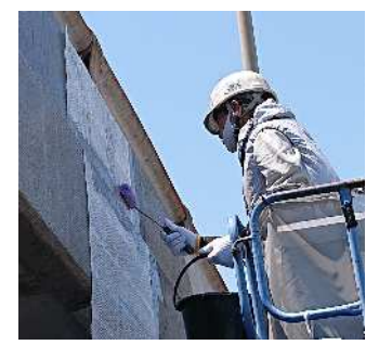
<剥落防止工施工状況>
