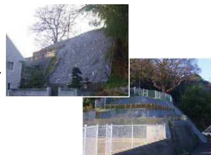
急傾斜地法面对策：施工後
