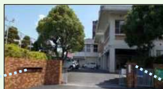
八幡西生涯学習総合センター折尾分館
