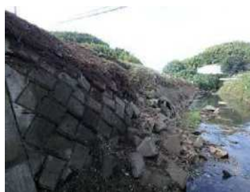
護岸整備：施工前
