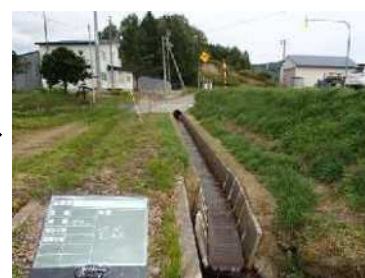
水路整備：施工後
