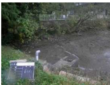
ため池堤体整備：施工前
