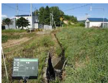
水路整備：施工前
