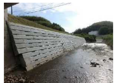
護岸整備：施工後
