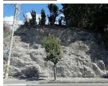
法面防護：施工後
