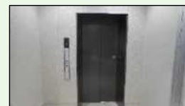
エレベーター(新設)
