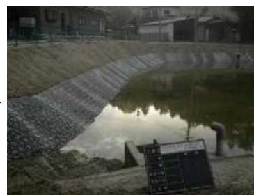
ため池堤体整備：施工後
