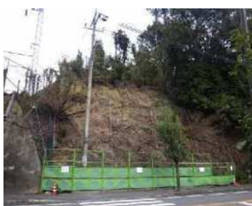
法面防護：施工前
