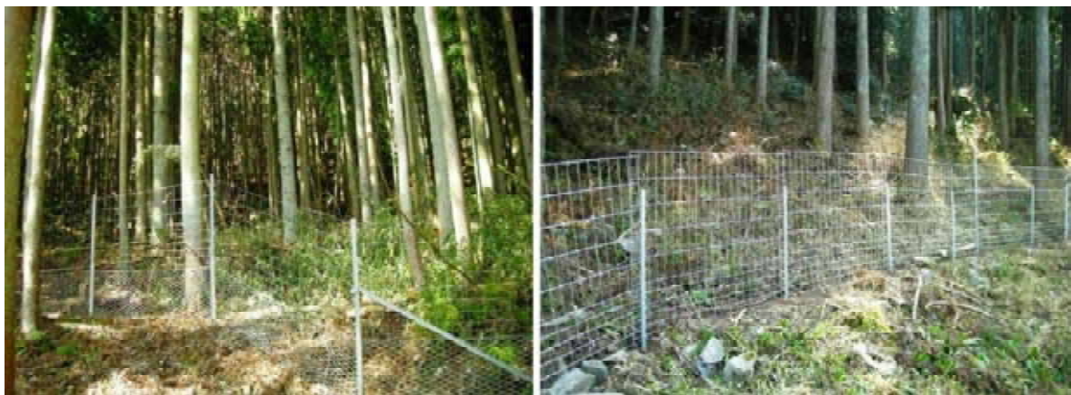
写真2 平成24年度に新城設楽地域に導入された大規模柵 （左：金網タイプ、右：ワイヤーメッシュタイプ）
