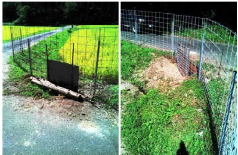
写真1 農地を直接囲ってイノシシに突破された大規模柵 （平成24年9月撮影、写真提供：新城市）
