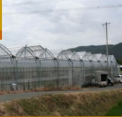
写真3 第4農場の外部、内部
