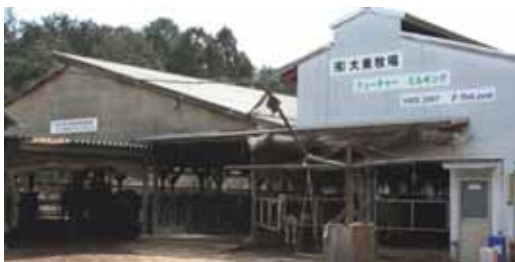
現在の牛舎(右側の建物に搾乳ロボットが入っている)
