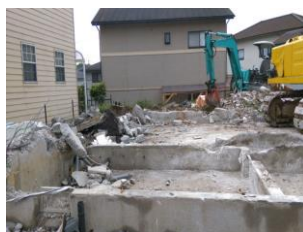
基礎の取り壊し
