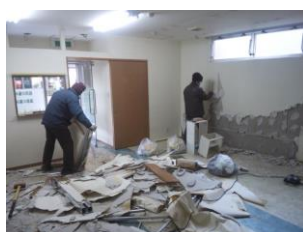
内装材の取り外し (原則、手壊し)
