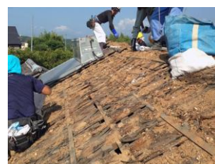
屋根ふき材の取り外し (原則、手壊し)
