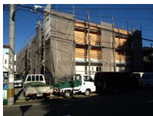
足場、養生の設置
