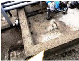
装置・タンクなどの周囲にコンクリート製の防液堤
