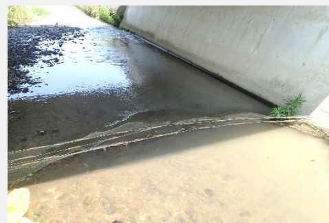
防除作業に伴う断片の流出防止のためのネット設置
