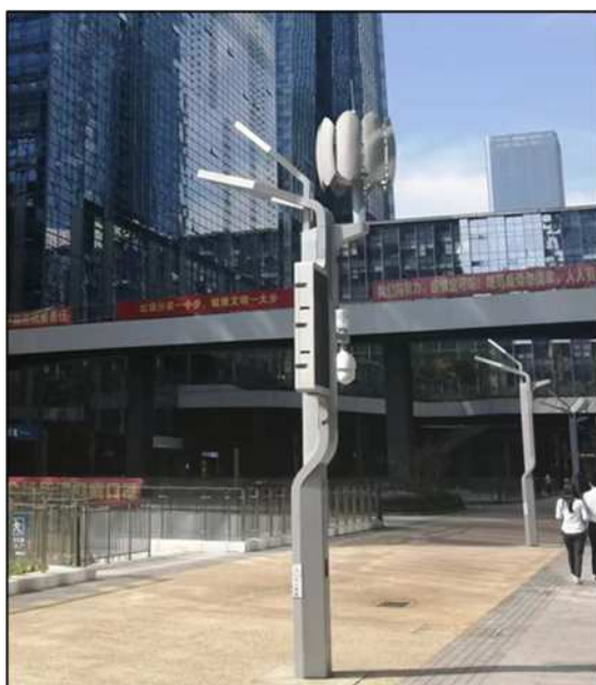
スマート電柱
