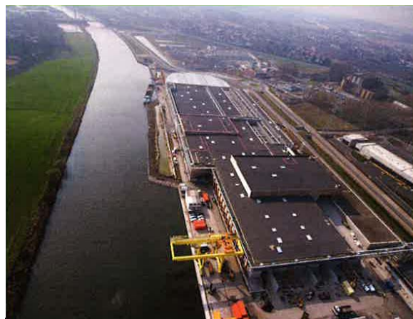
リールのバイオガス・プラント (5.7ha) ・左は運河、船によって他の処理場と往来 ・右はガス燃料車両用のガススタンド
