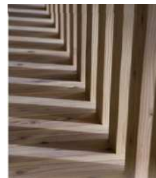
あいち認証材の杉材を使用した天井
