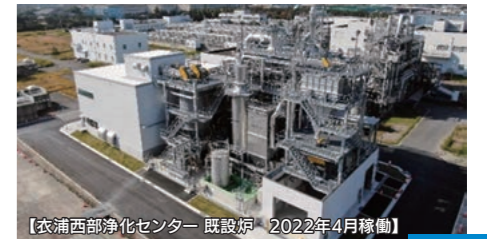
【衣浦西部浄化センター 既設炉 2022年4月稼働】 事業実施中
