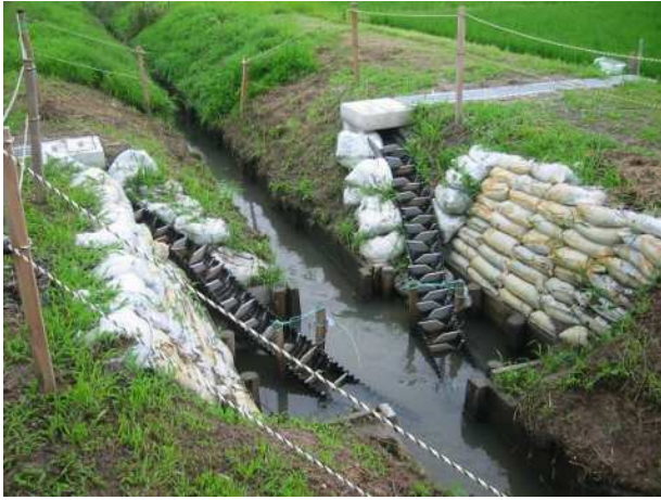
写真3 魚道の設置状況
