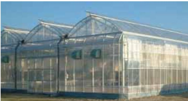
パイプ斜杭基礎工法やユニット工法などにより、低コスト（建設費が従来施設の約57%）を実現した高軒高ハウスです。
