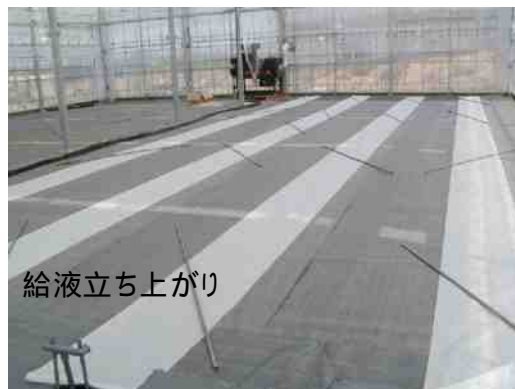
写真3 防根シート設置後
