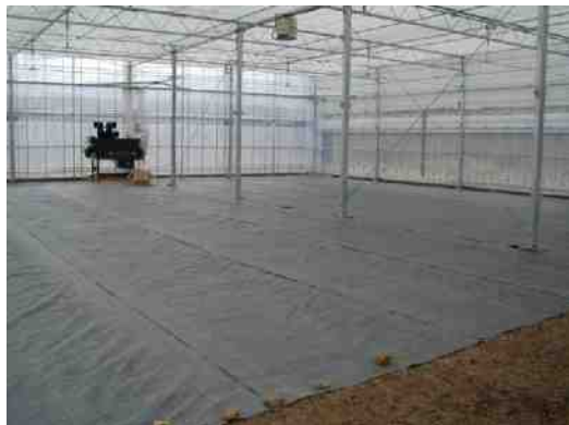
写真2 下敷シート設置後
