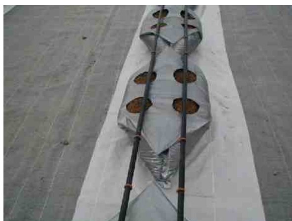
写真19 通水テスト後の状況
