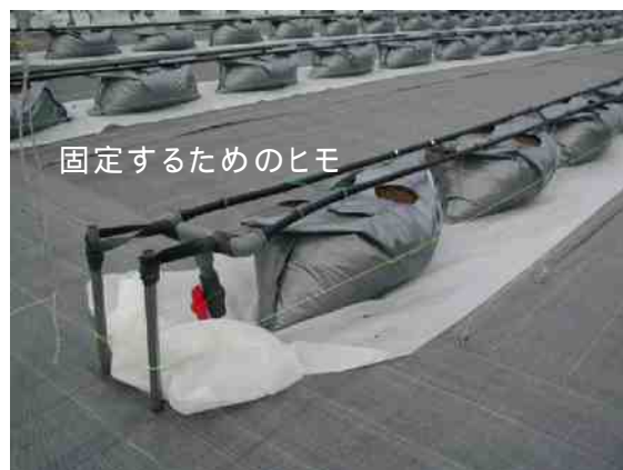
写真17 後端部固定例
