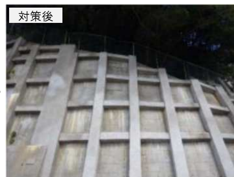
急傾斜地崩壊防止施設の修繕工事(間草区域)
