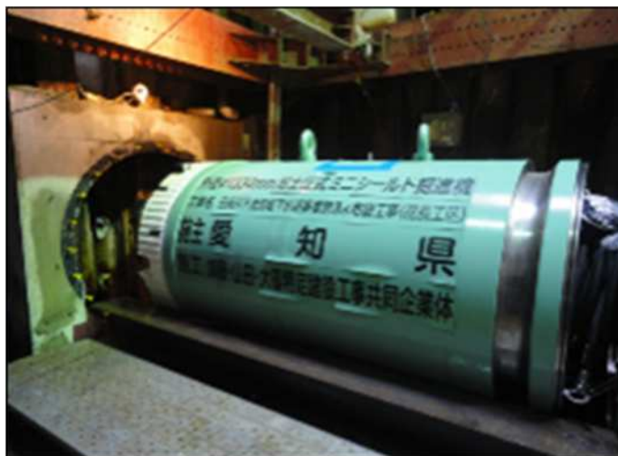
幹線管渠整備状況 (日光川下流流域下水道)
