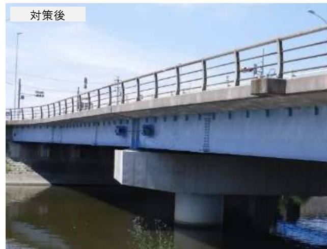
橋梁の耐震補強(県道蟹江飛島線 新善太川橋)
