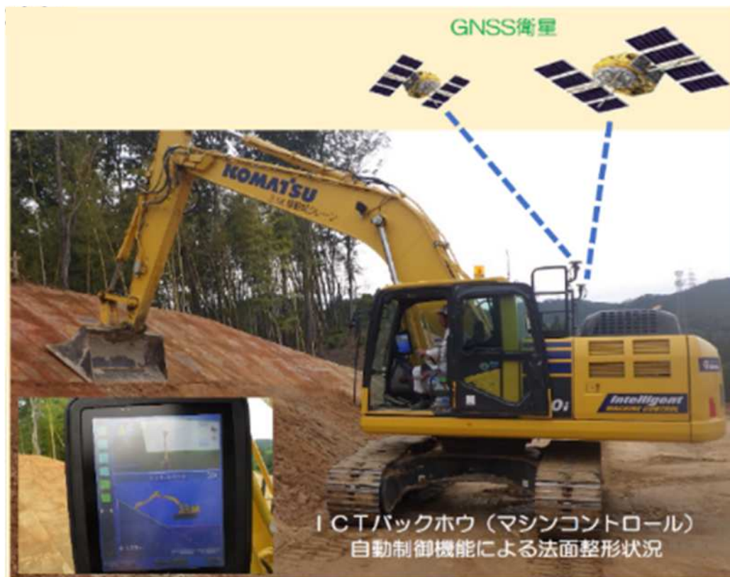
ICTバックホウによる法面整形
