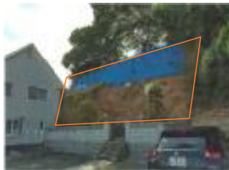
急傾斜地法面対策：施工前
