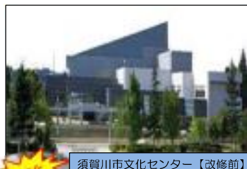
須賀川市文化センター【改修前】
