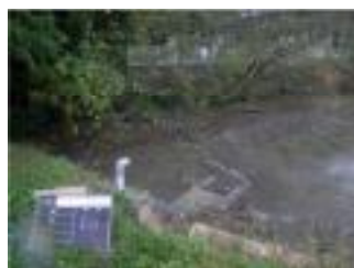
ため池堤体整備：施工前
