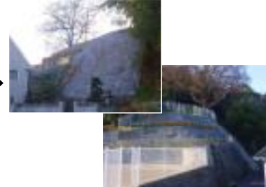
急傾斜地法面対策：施工後
