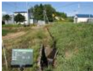
水路整備：施工前
