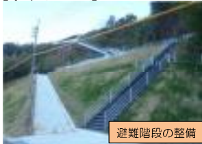
避難階段の整備
