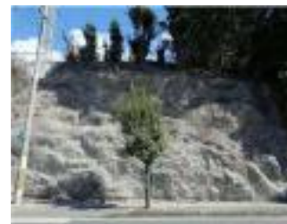
法面防護：施工後
