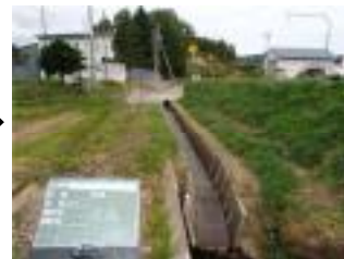
水路整備：施工後
