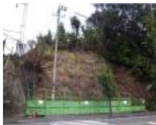
法面防護：施工前
