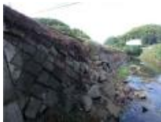
護岸整備：施工前
