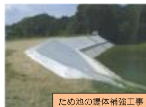
ため池の堤体補強工事
