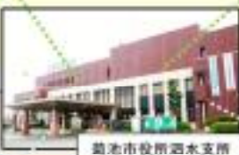
菊池市役所泗水支所
