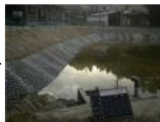
ため池堤体整備：施工後
