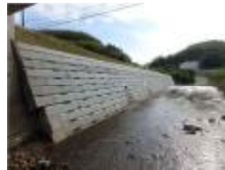
護岸整備：施工後
