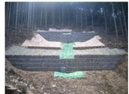
山腹崩壊地の復旧状況
