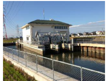
たん水防除事業北浜南部1期地区 (西尾市 行用排水機場)
