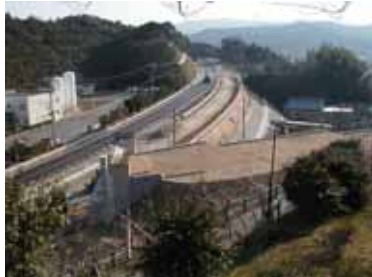
【 国道248号(幸田町) 】
