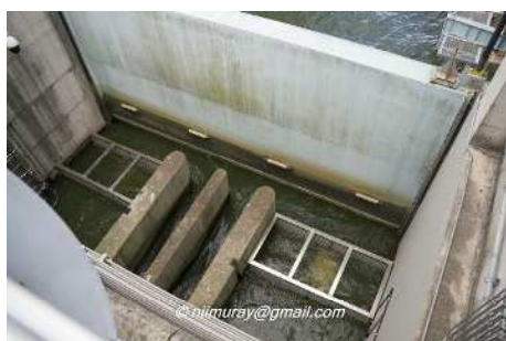
階段式魚道最上流部。二列で構成され中央に水路式魚道？（呼び水水路？）がある。階段式魚道の上に枠で仕切られた柵があるが、これは、ウライ（サケ捕獲用のトラップ？）かもしれない。
