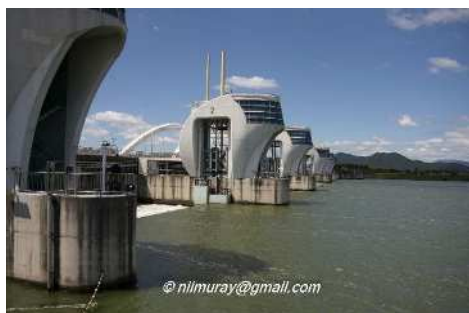
右岸側河口堰の全景（左岸上流より）
