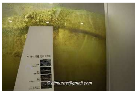
魚道観察窓。魚道の隔壁には、マニラ麻ロープが沿わせてあり、モクズガニ用魚道とされている（長良川河口堰で開発された魚道）。流速は緩い（30cm 毎秒程度、遊泳力の小さな魚類も登れそうに見える、視察時）
