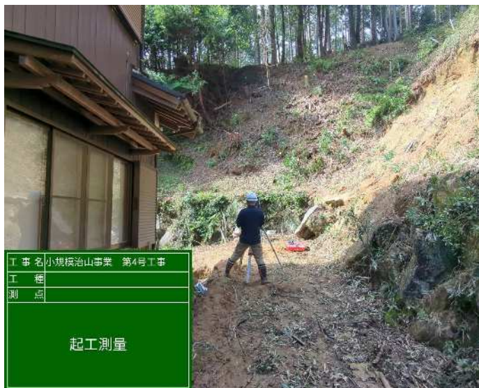
地上型レーザースキャナーを用いた起工測量
