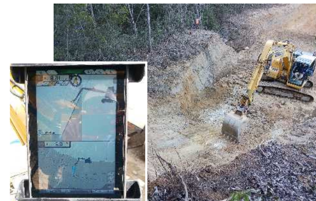
3次元MGバックホウによる掘削状況
