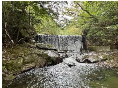
砂防施設(砂防堰堤)
