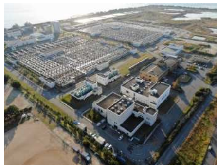
上工下水道施設(下水処理場)
