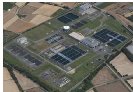
上工下水道施設(浄水場)
