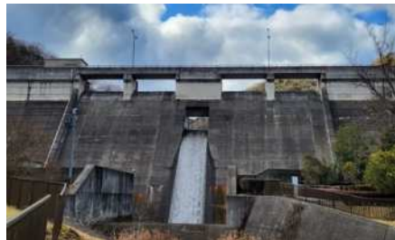
河川施設(ダム)
