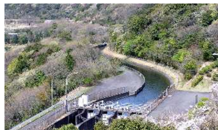
農業水利施設(農業用水路)
