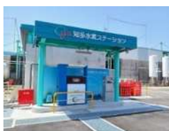
水素ステーション
