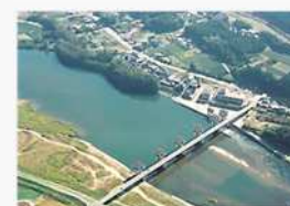
牟呂松原頭首工
