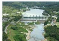
明治用水頭首工
