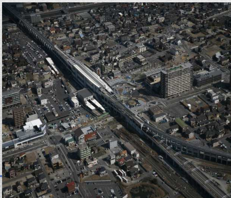
東海太田川 連続立体交差事業
