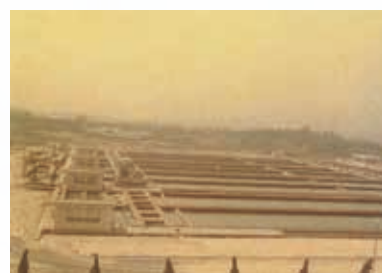
水道2期拡張工事
