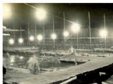
夜間を通じての工事
