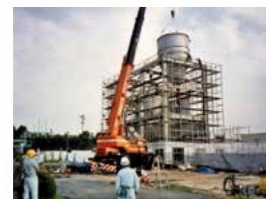
活性炭注入設備の工事
