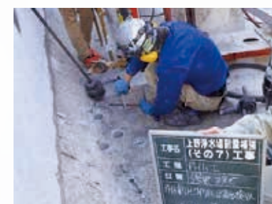
コンクリート構造物の耐震化工事
