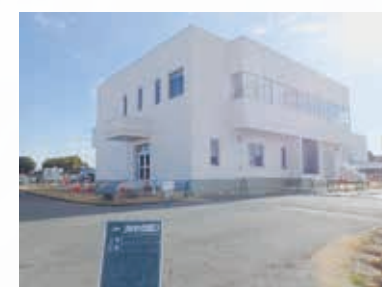
中央管理棟の竣工
