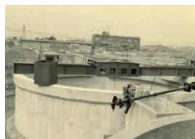
排水処理施設工事
