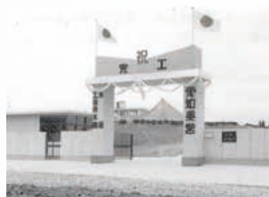
昭和36年 上野浄水場通水式
