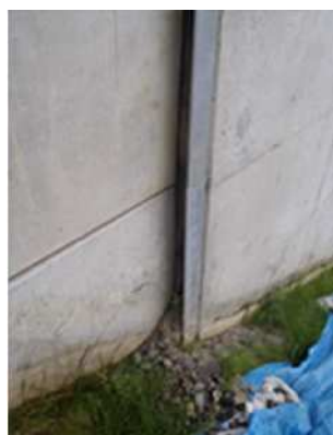
写真 土砂のこぼれ出し例
