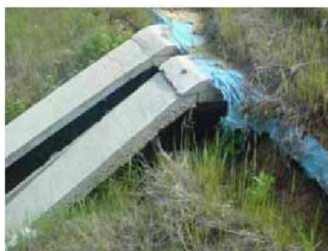
(b) 崩壊性の沈下により排水施設等の下部に空洞が生じている例
