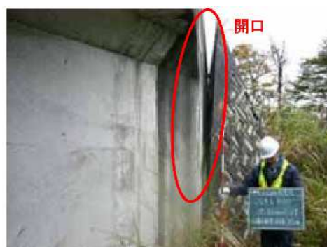
写真 ウイングと坑口擁壁 間の開口の例
