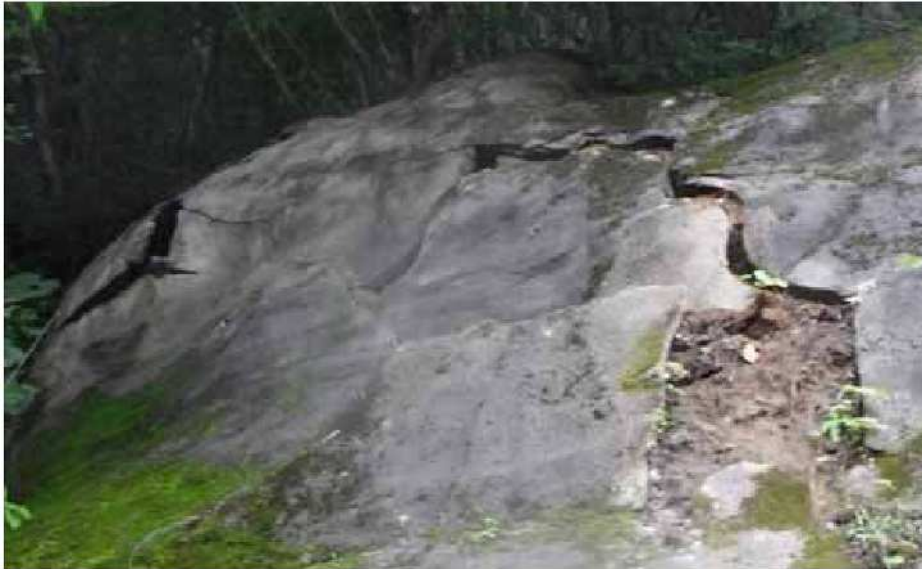
(a) 吹付工の開口亀裂、剥離、空洞および地山の露出
