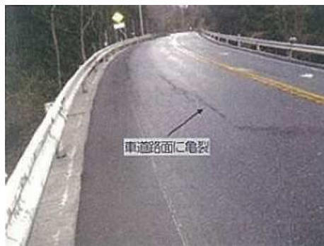
写真 路面の円弧状クラックの例
