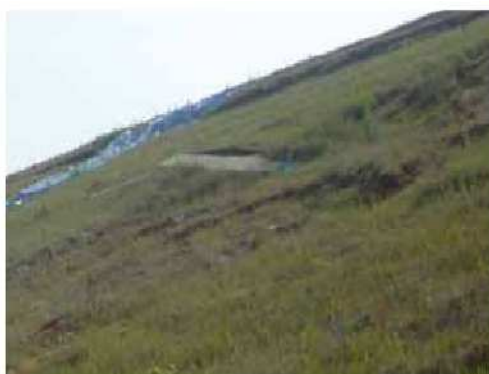
(a) のり面全体に崩壊が生じている例
