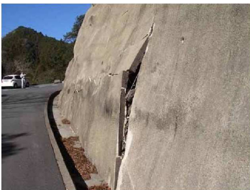
(b) 吹付のり面の目地部分でのずれおよびはらみだし
