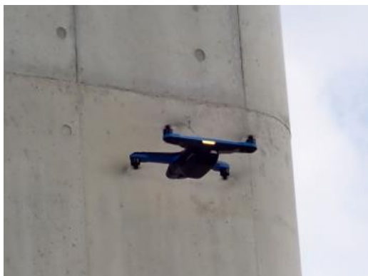
写真 3-1 全方向衝突回避センサーを有する小型ドローン技術（38 橋梁）
