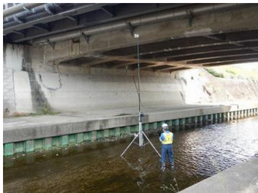
写真 3-3 橋梁等構造物の点検ロボットカメラ技術（18 橋梁）
