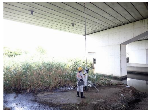
写真 3-6 橋梁等構造物の点検ロボットカメラ技術 (2 橋梁)
