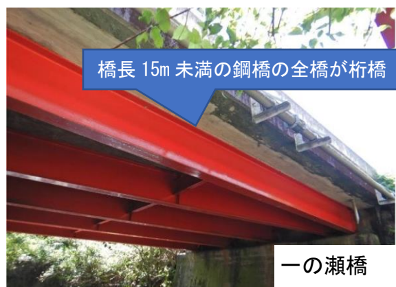
写真 1-1 鋼橋の状況（橋長 15m 未満）
