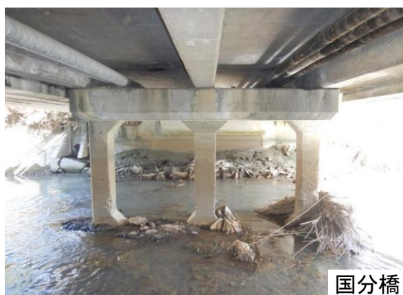
写真 1-2 複数径間橋梁の状況（橋長 15m 未満）
