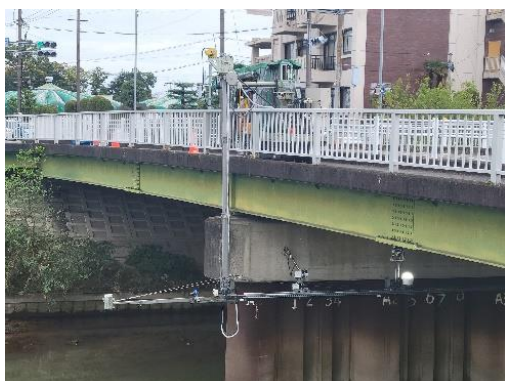
写真 3-7 視る・診る (1 橋)
