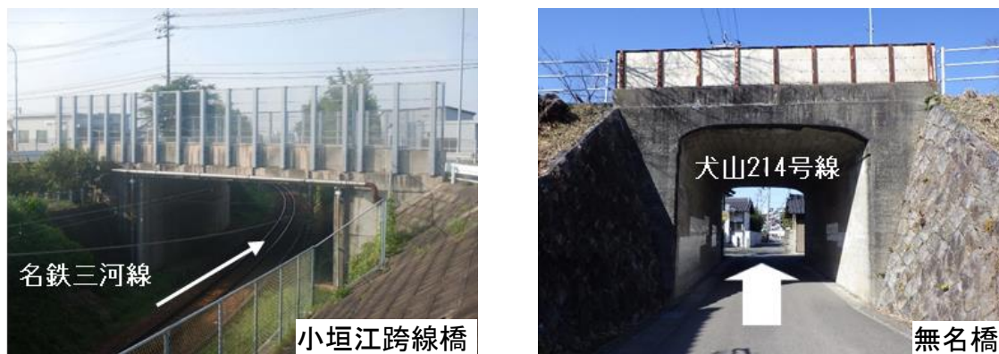
写真 1-3 第三者被害が想定される橋梁の状況（橋長 15m 未満）
