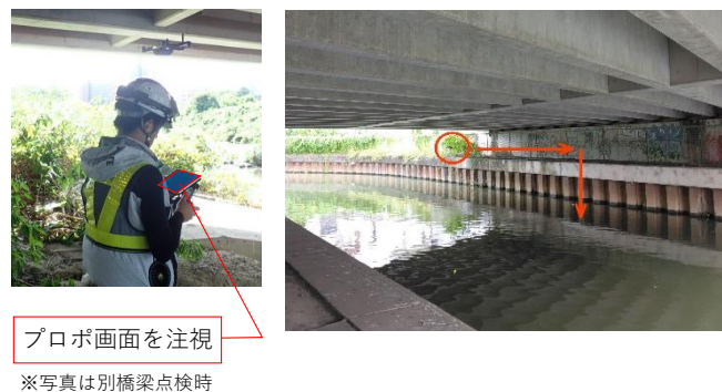
写真 3-9 ドローン落下事故状況
