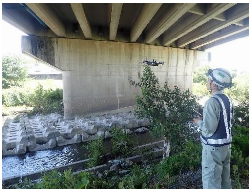
写真 3-5 全方向衝突回避センサーを有する小型ドローン技術 (26 橋梁)
