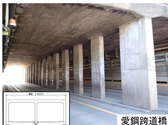
写真 1-2 複数径間橋梁の状況（橋長 15m 未満）
