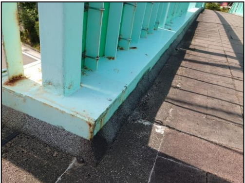
写真 3.5.9-2 舗装端部処理事例(通路部)
