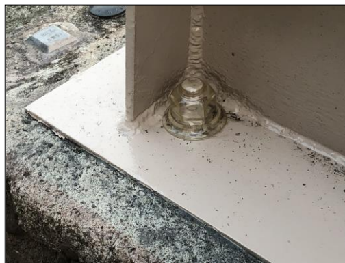
写真 3.5.7 保護キャップの設置事例(参考)
