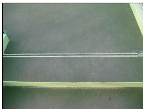
写真 3.5.9-10 接合部の補修事例
