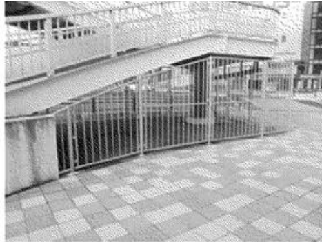
写真 3.5.8 立入防止柵設置事例（参考）
