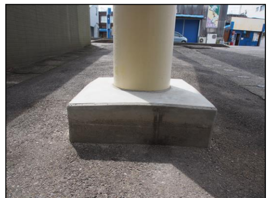
写真 3.5.9-6 橋脚基部の補修事例
