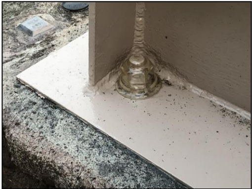
図 3-32 保護キャップの詳細構造(参考)
