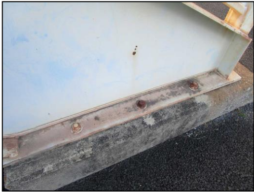
図 3-32 保護キャップの詳細構造(参考)
