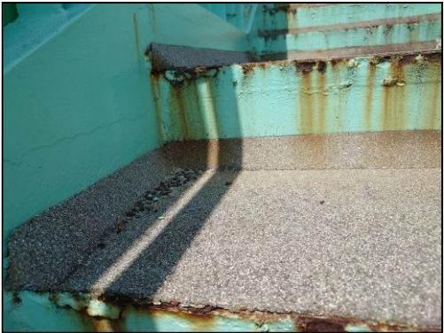
写真 3.5.9-1 舗装端部処理事例(階段部)
