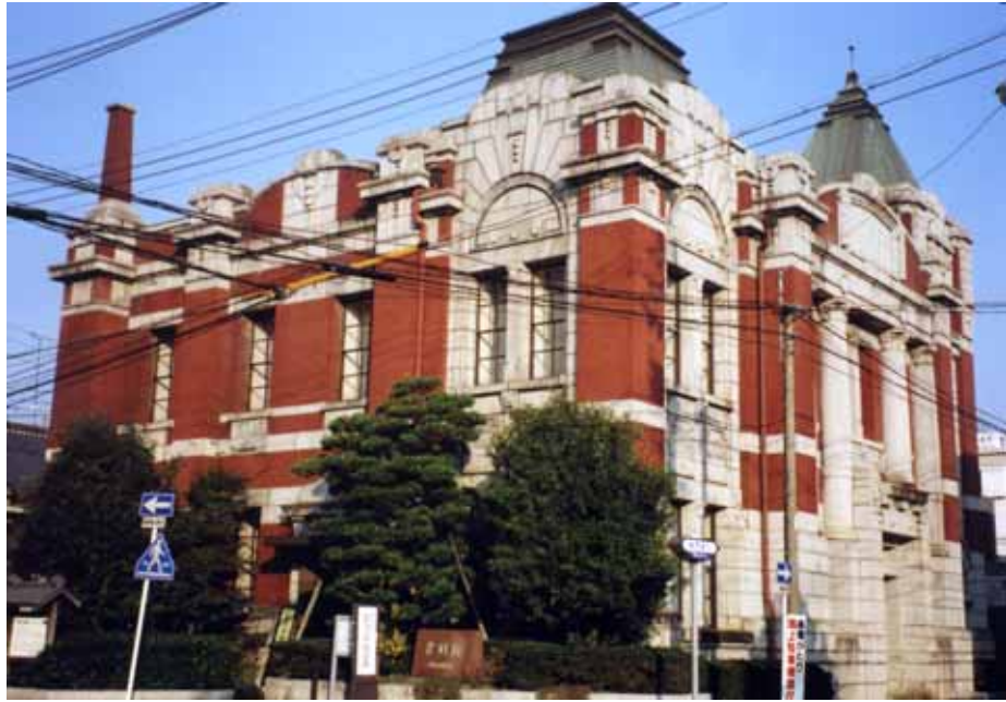
岡崎信用金庫資料館（旧岡崎銀行本店）南西から
