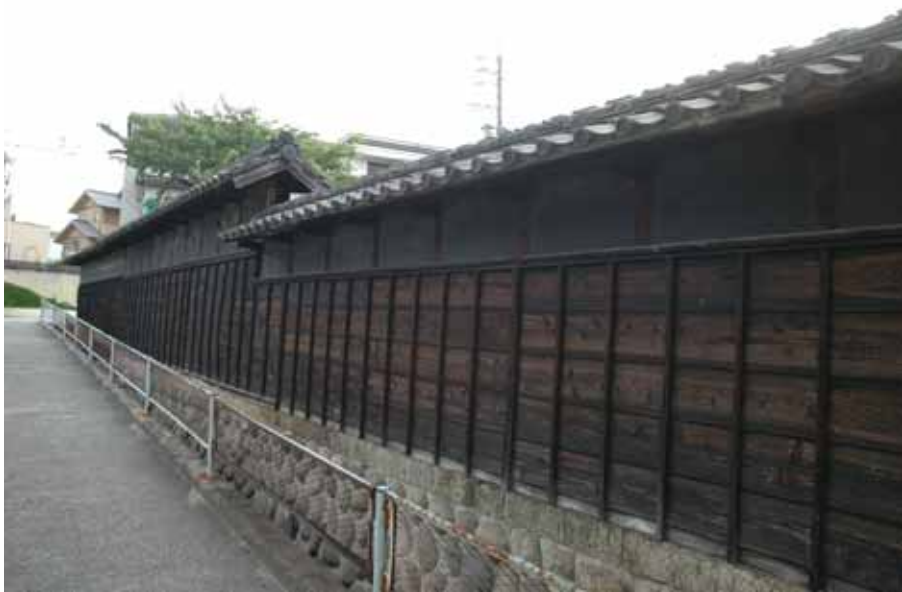
中濱家住宅石垣及び塀
