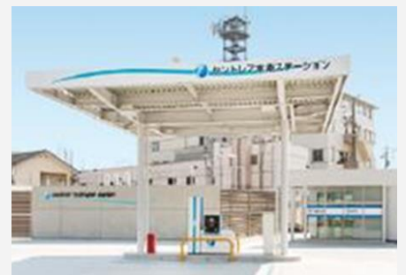
水素ステーション
