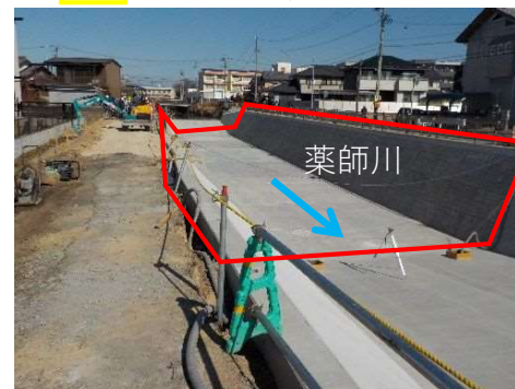
⑦薬師川：橋梁改築、河道整備
