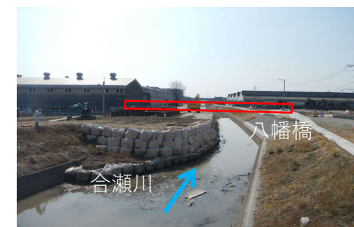
④合瀬川：橋梁改築、河道整備
