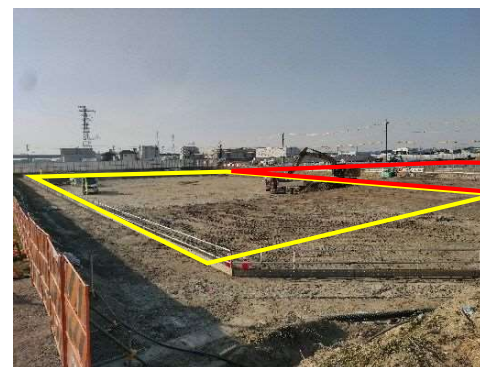
⑦大山川調節池：本体整備
