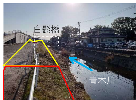
⑤青木川：河道整備
