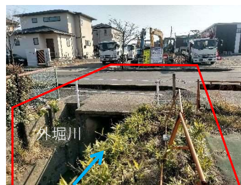
⑨外堀川：橋梁改築
