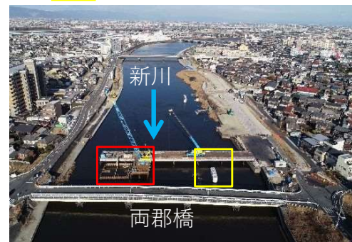
①新川：橋梁改築
