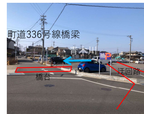
⑩青木川：橋梁改築
