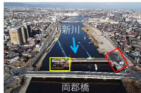
①新川：橋梁改築
