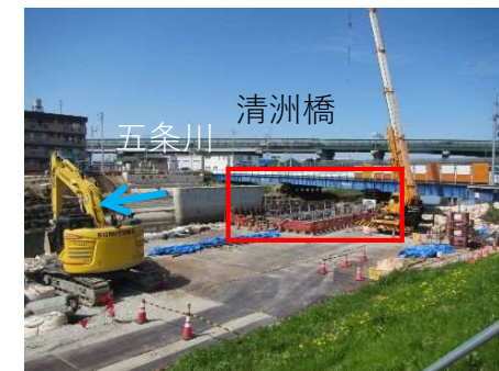
②五条川：橋梁改築
