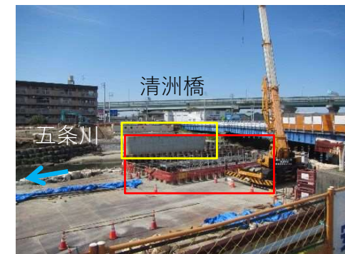
②五条川：橋梁改築
