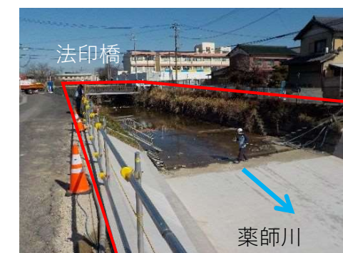
⑥薬師川：橋梁改築、河道整備
