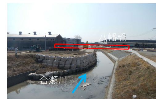
④合瀬川：橋梁改築、河道整備
