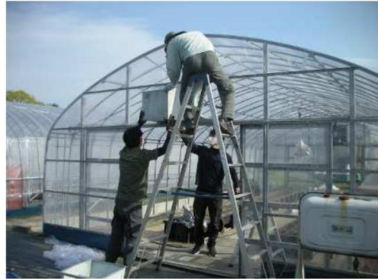
栽培試験に使っているビニルハウスの被覆ビニル張り替え作業を実施しました。換気口や加温器の煙突周りなどは工夫が必要で、農家の方々のご苦勞の一端を実感しました。新しい被覆になり、ハウスの中が明るくなりました。
