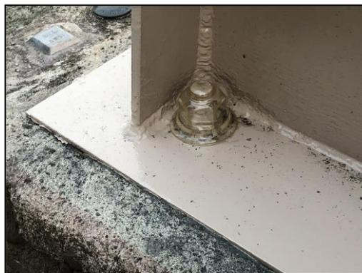
写真 3.5.7 保護キャップの設置事例(参考)
