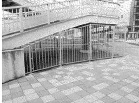
**写真 3.5.8 立入防止柵設置事例（参考）**
