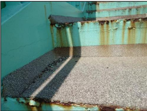
写真 3.5.9-1 舗装端部処理事例(階段部)
