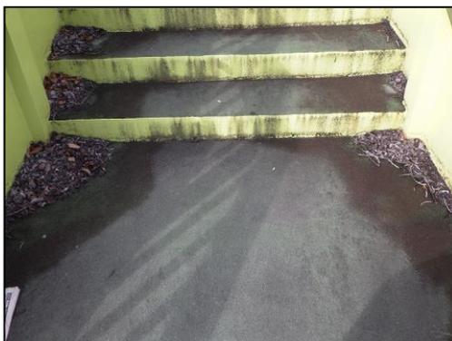
写真 3.5.9-3 踊り場部の土砂堆積事例
