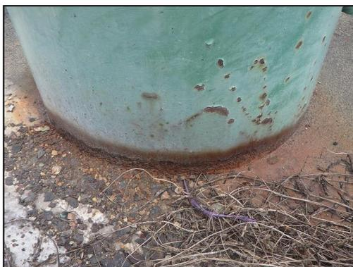
写真 3.5.9-5 橋脚基部の腐食事例
