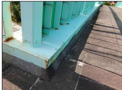
写真 3.5.9-2 舗装端部処理事例(通路部)
