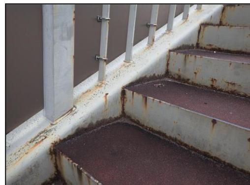
写真 3.5.9-4 階段部の腐食事例
