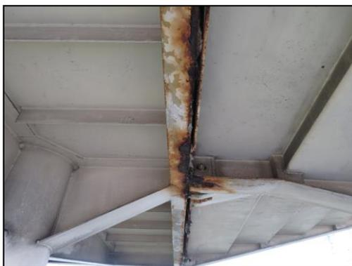
写真 3.5.9-9 接合部の腐食事例
