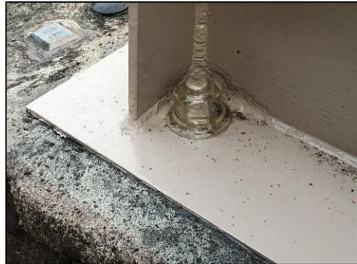
写真 3.5.9-8 アンカーボルトの補修事例
