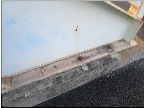
写真 3.5.9-7 アンカーボルトの腐食事例
