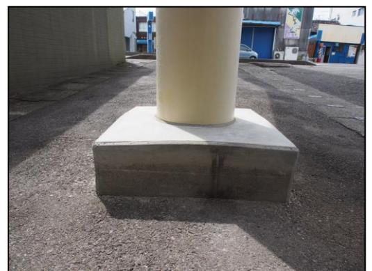
写真 3.5.9-6 橋脚基部の補修事例
